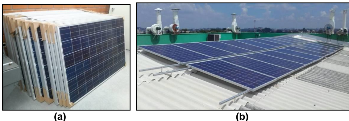
Figura 13 – Painel Solar – (a) Módulos – (b) Instalação dos 22 Módulos
