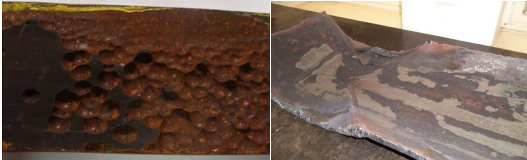
Figura 4- a) Parede interna da torre de condensação b) parede interna da tubulação
