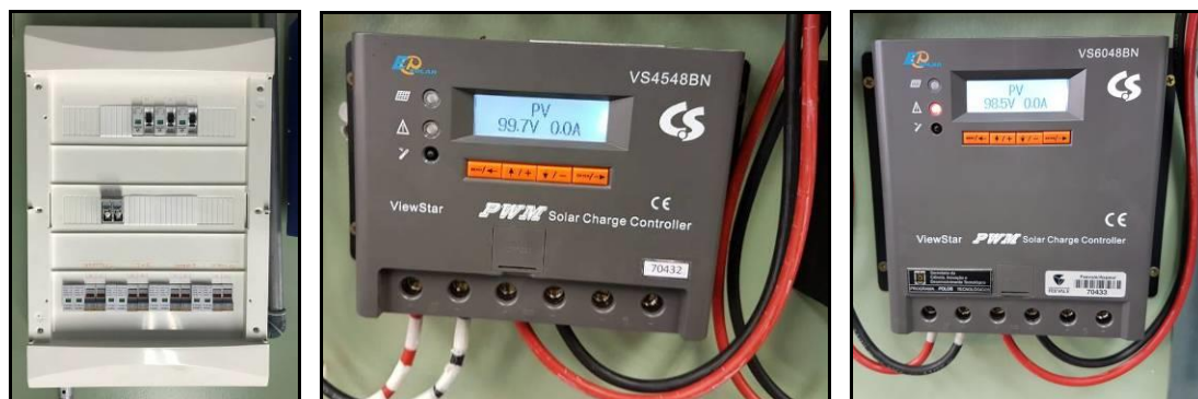
(a) (b) (c) Figura 14 – Controladores do Painel tipo PWM ViewStar da Epsolar – (a) Quadro de Conexões e Proteção – (b) VS4548BN para dois conjuntos de 6 Módulos – (c) VS6048BN para 10 Módulos
